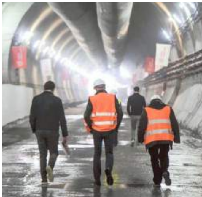
Il cantiere del Terzo valico ferroviario dei Giovi
